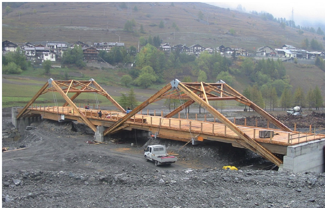
Bild 2: Behauholz bei der Errichtung einer Brücke für das Langlauf- und Biathlonzentrum der XX. Olympischen Winterspiele in Pragelato, Torino
